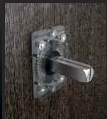
detail upevnění kliky v 6 bodech
