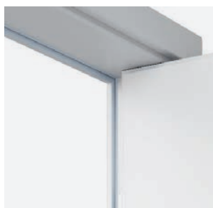
Roh zárubně z vnitřní strany
